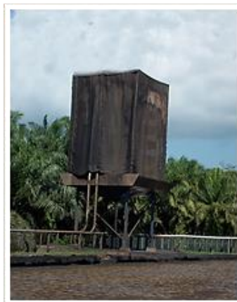
Figura 8. Laguna de enfriamiento
