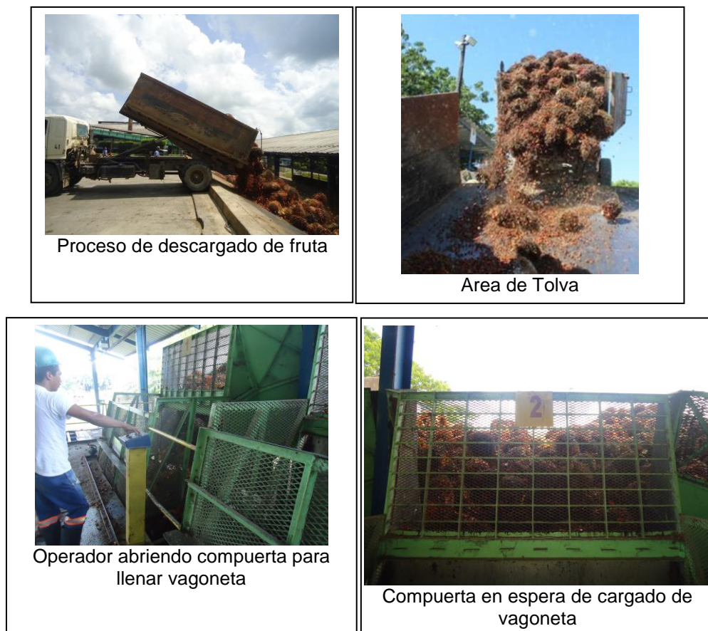
Figura 17. Área de tolva
