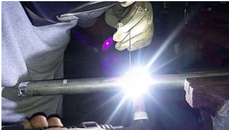
Figura 20. Proceso de soldadura TIG
