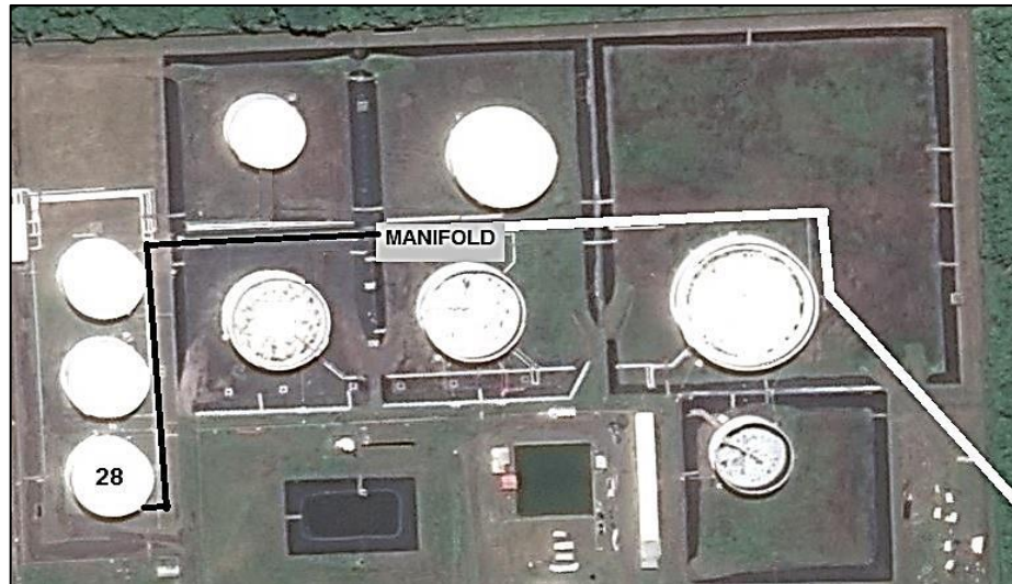
Figura 29. Distribución de fuel oil hacia los tanques de almacenamiento a través del Manifold de recepción
