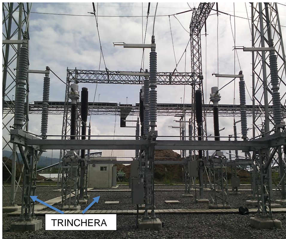
Figura 55. Trinchera de subestación
