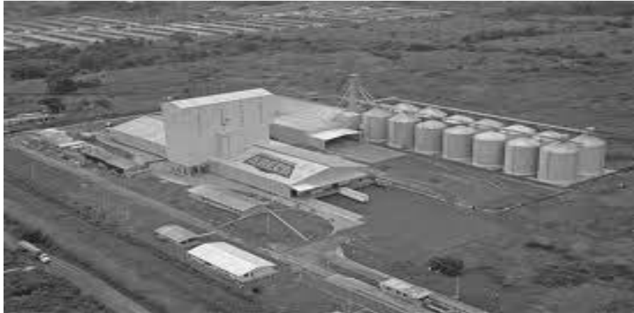
Figura 1. Vista aérea de la planta Areca
