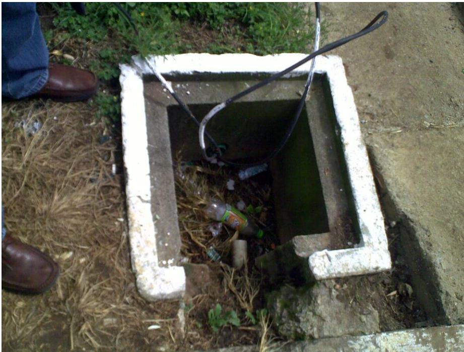
Figura 6. Espacio para tierra física
