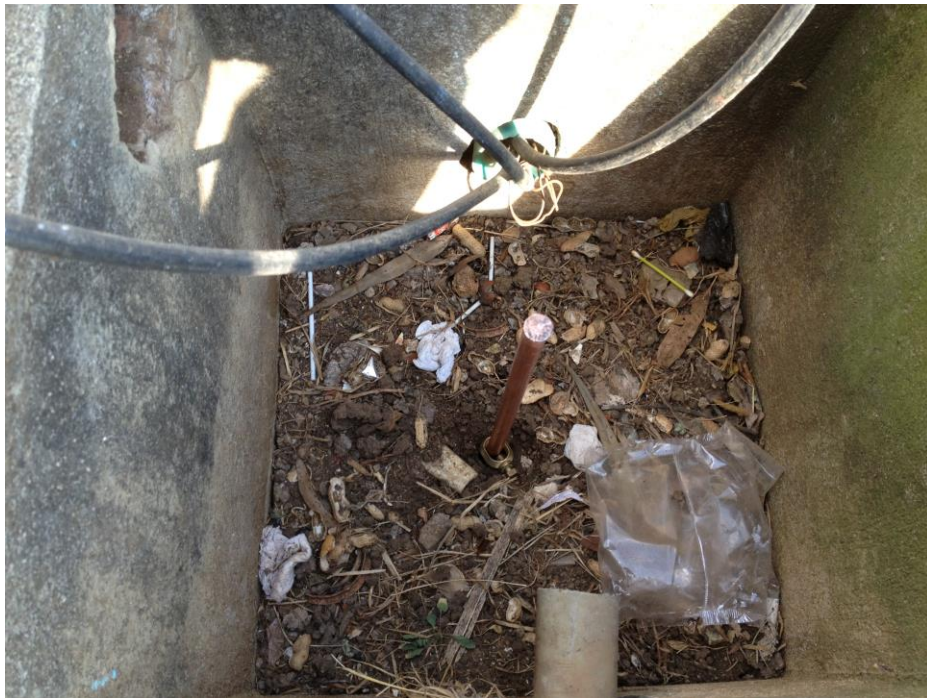
Figura 16. Estado anterior del espacio para tierra física
