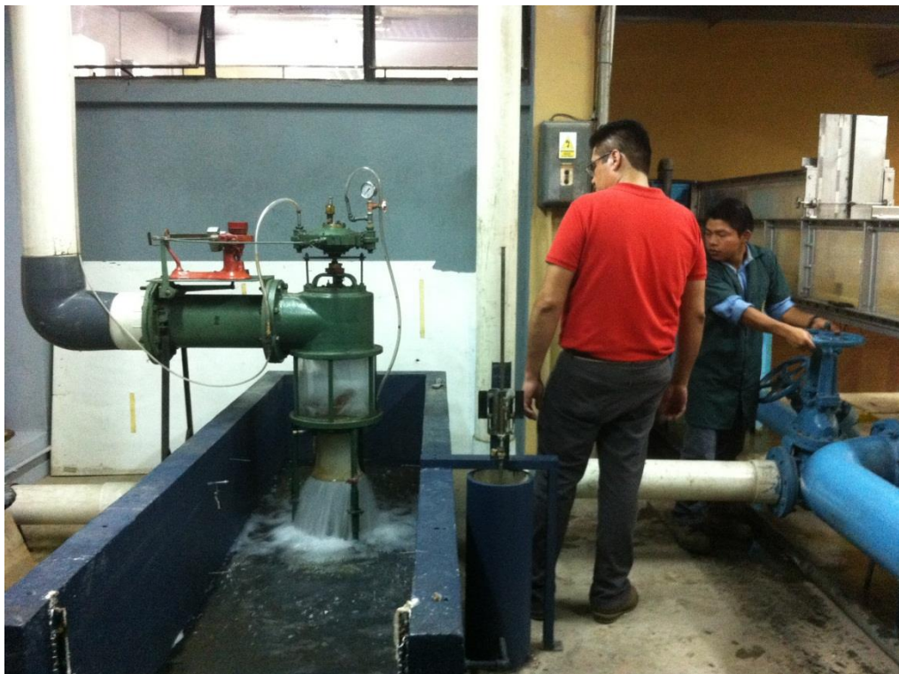
Figura 39. Arranque de la turbina
