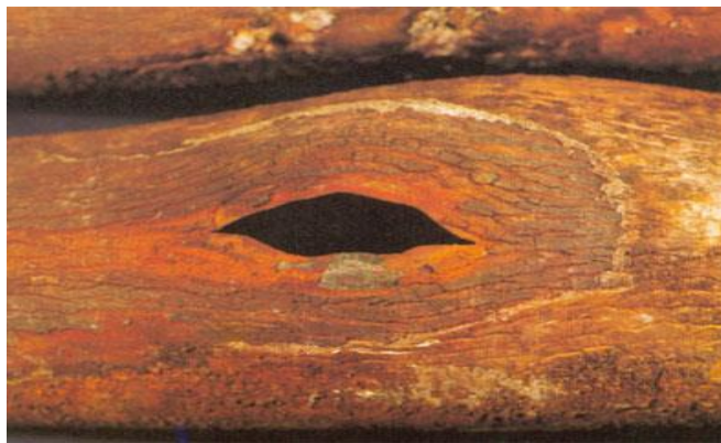
Figura 5. Corrosión por ácido carbónico
