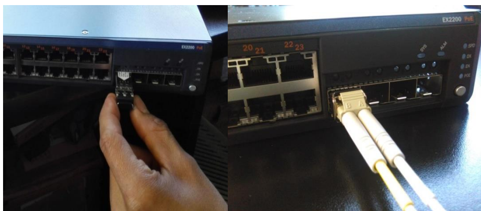
Figura 22. Instalación de fibra óptica
