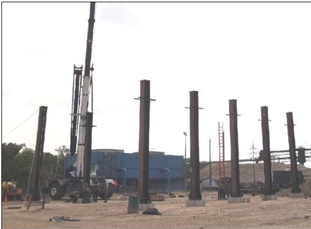
Figura 32. Montaje columnas principales
