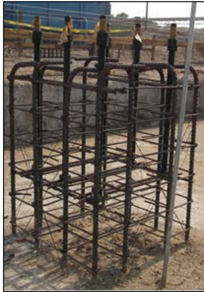
Figura 30. Estructura de pedestal
