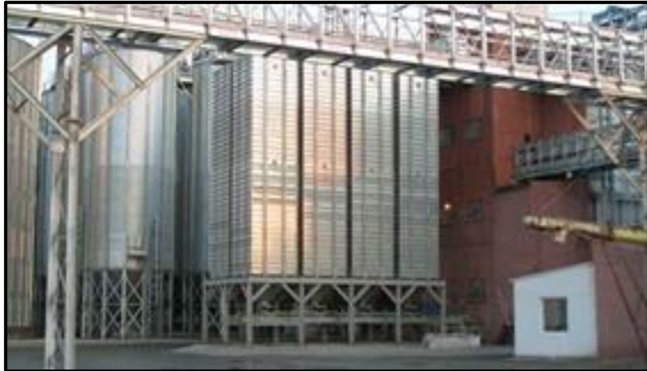
Figura 14. Silo cuadrado de chapa trapezoidal
