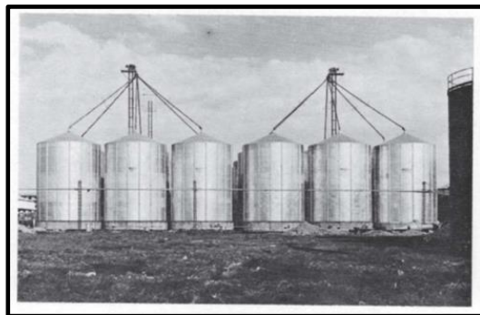
Figura 12. Silo metálico de chapa lisa
