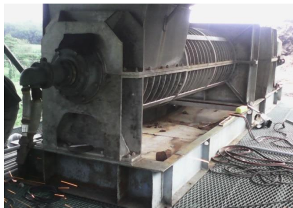
Figura 57. Instalación de prensa desaguadora de tornillo
