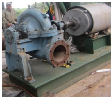
Figura 61. Instalación de motor y bomba # 2, de agua limpia
