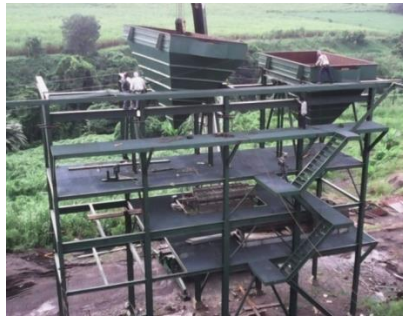
Figura 43. Instalación de tolvas decantadoras de lodos en estructura
