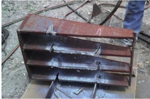
Figura 40. Construcción de un cargador de tolva decantadora de lodos
