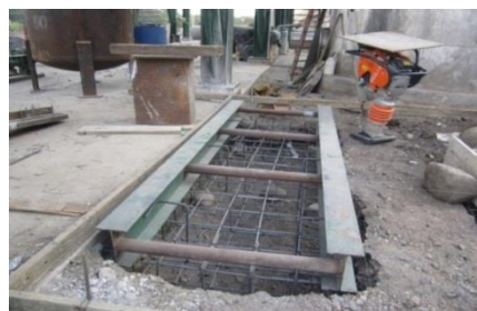
Figura 50. Construcción de bases para tanques de floculante
