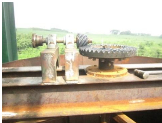
Figura 47. Mecanismo del agitador de lechada de cal
