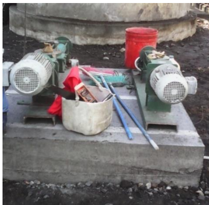
Figura 64. Instalación de bombas de floculante
