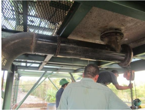
Figura 80. Instalación de tubería para agua filtrada del filtro rotativo
