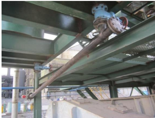
Figura 79. Instalación de tubería de lechada de cal
