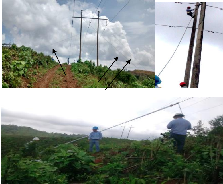
Figura 50. Aseguramiento de la estructura por medio de garruchas
