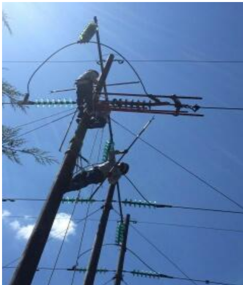
Figura 35. Instalación del yugo trasero del bastidor doble
