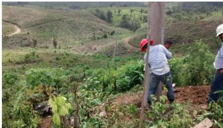
Figura 52. Compactación de la tierra y piedras dentro del agujero
