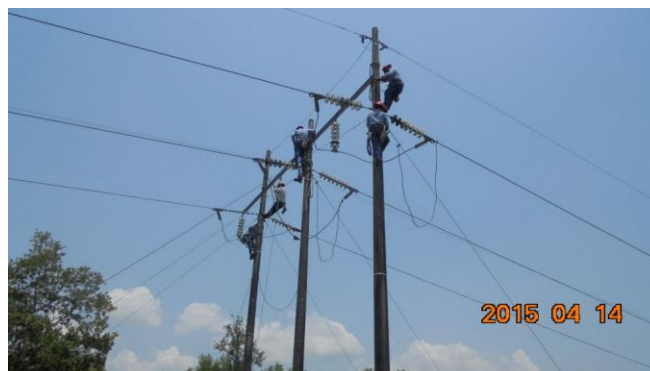
Figura 41. Instalación de conductores en los aisladores
