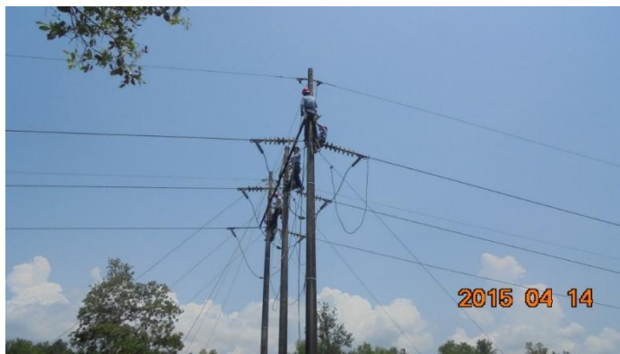
Figura 38. Removiendo la tornillería del crucero
