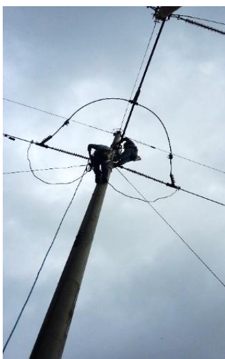
Figura 45. Cambio de empalme finalizado
