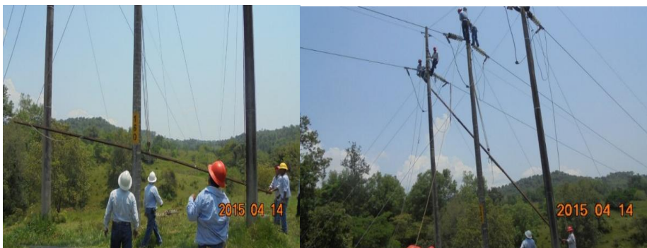
Figura 40. Ascenso del crucero a la estructura
