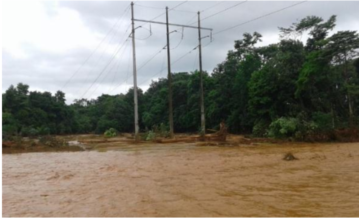
Figura 23. Estructura en riesgo desastre natural
