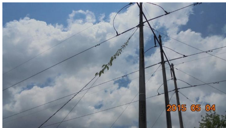
Figura 9. Estructura de remate ángulo de 0 grados
