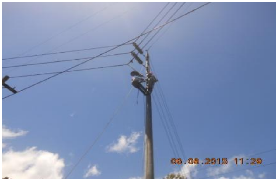
Figura 34. Cambio de aisladores en línea des-energizada
