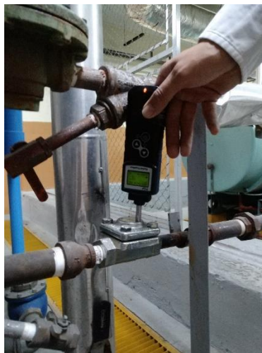
Figura 12. Inspección de la trampa de vapor
