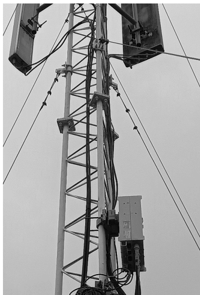
Figura 18. Unión pernada de dos secciones de torre arriostrada
