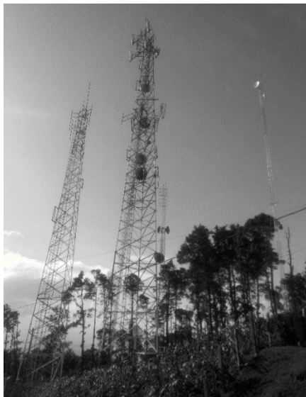
Figura 3. Torres autoportadas ubicadas en Baja Verapaz
