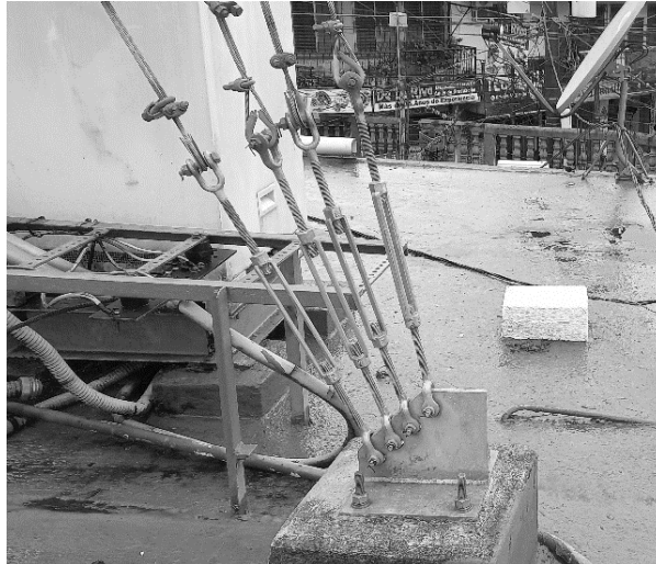
Figura 17. Platina de anclaje de torre arriostrada
