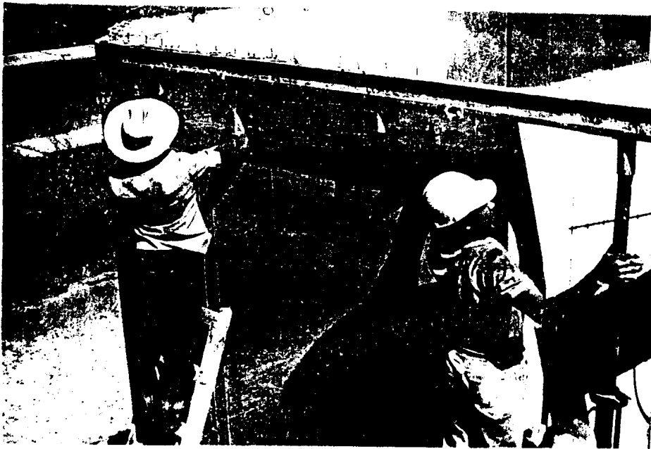
COLOCACION DE ELEMENTOS DE APOYO DE TARIMA
