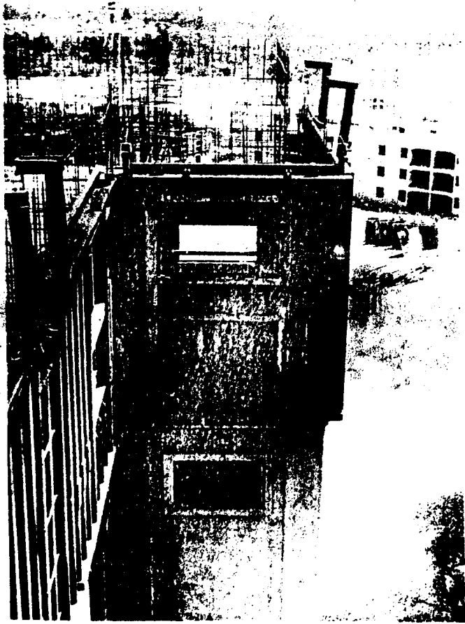
FORMALETA EXTERIOR COLOCADA
