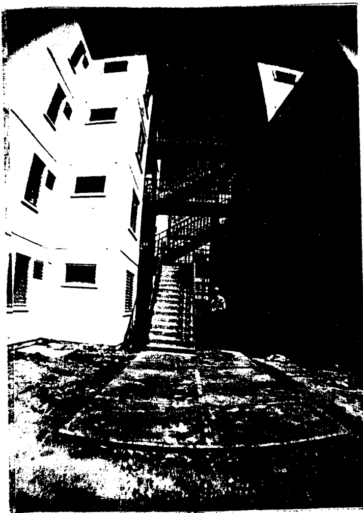
TORRE DE ESCALERAS TERMINADA FOTOGRAFIA No 42
