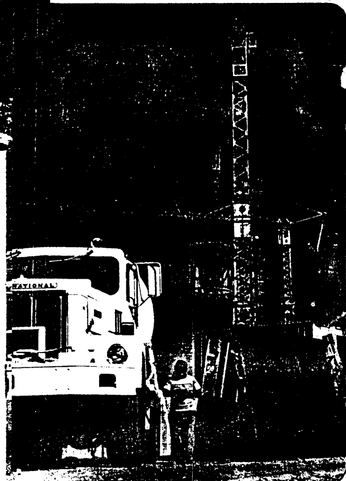
FUNDICION CON GRUA TORRE Y CUCHUMBO FOTOGRAFIA No 34
