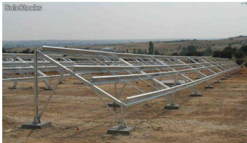
Fuente: *Estructura metálica de soporte para módulos fotovoltaicos.*
