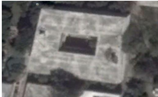
Figura 41. Vista satelital del edificio S7
