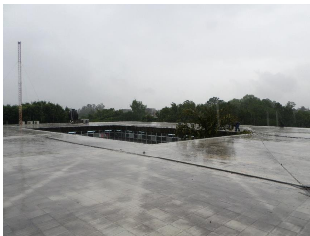
Figura 40. Área disponible en la terraza del edificio S7
