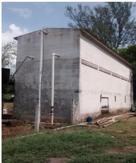
Figura 51. Tubería de alta presión 250 psi de PVC
