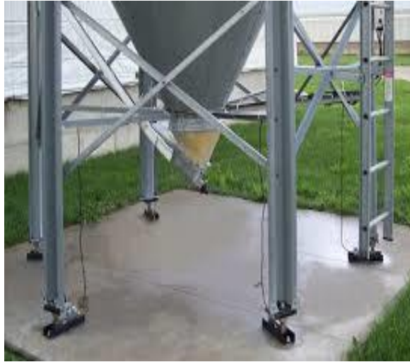
Figura 53. Instalación de tierras físicas con bases en los silos
