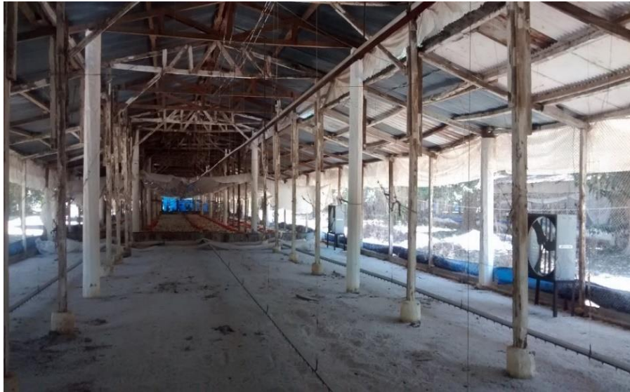
Figura 5. Galera tipo convencional con estructura de madera
