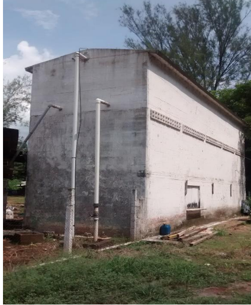
Figura 20. Tanque de agua aéreo
