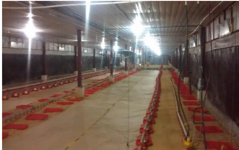
Figura 7. Galera tipo túnel con ventilas, criadoras y sistemas de comederos
