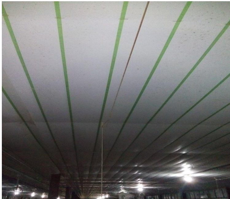
Figura 84. Cielo falso de una galera túnel
