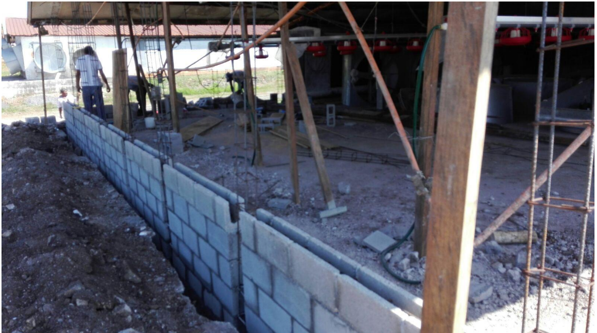
Figura 39. Construcción de área para transformador pad mounted
