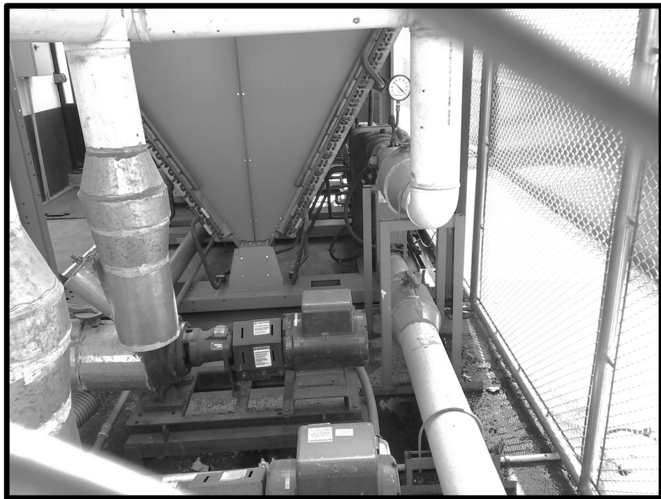
Figura 14. Sistema de bombeo de agua helada
