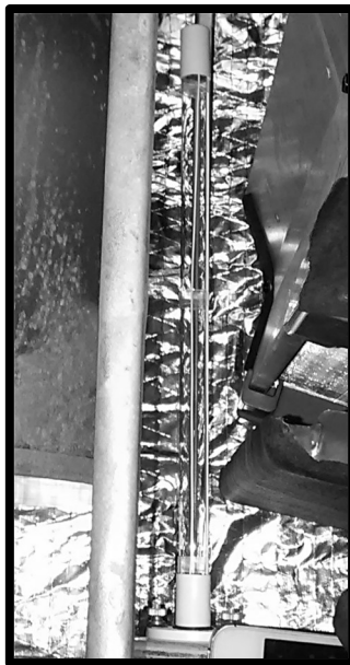
Figura 9. Sistema de purificación de aire por UV
