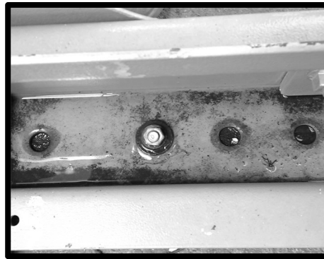
Figura 24. Anclaje del equipo chiller
