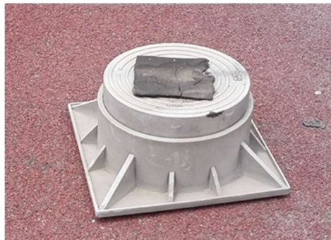
Figura 27. Base instalada en condensadores
