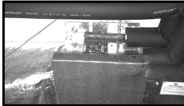
Figura 25. Anclaje de unidad Fan coil
