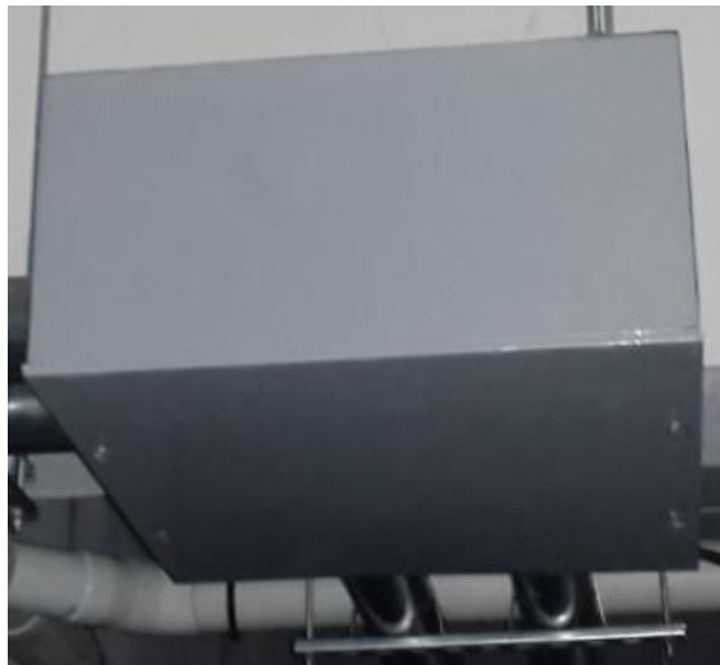
Figura 12. Registro metálico suspendido
