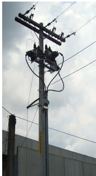
Figura 22. Medición primaria de remate
