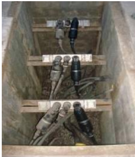
Figura 19. Barras de derivación de 3 posiciones
