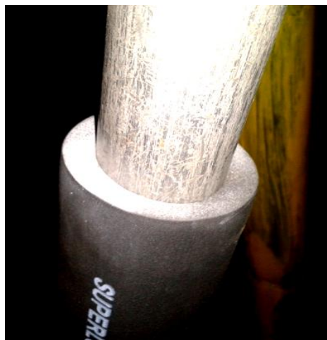
Figura 18. Aislamiento térmico con armaflex
