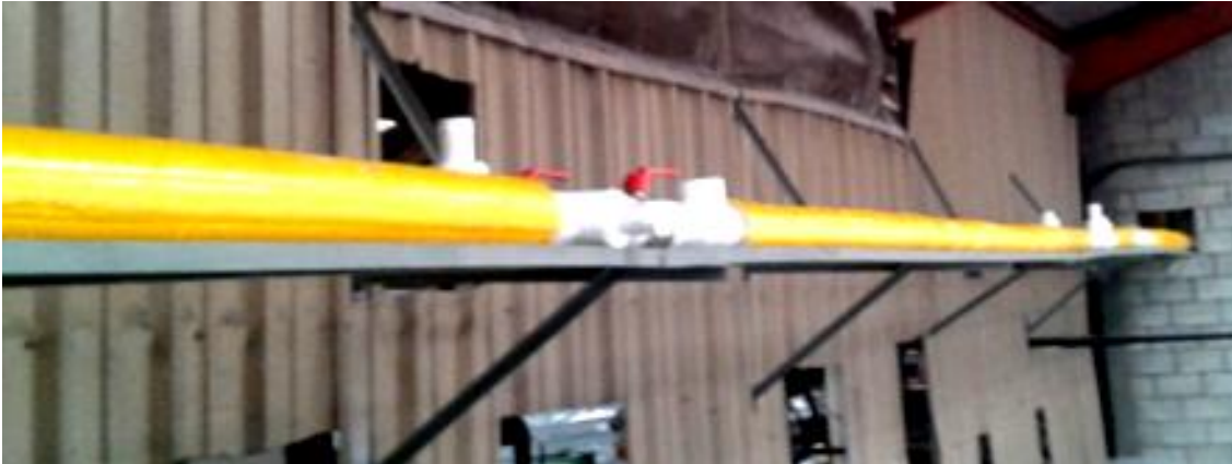
Figura 48. Instalación de tubería central de agua
