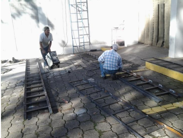
Figura 41. Fabricación de parillas de soporte
