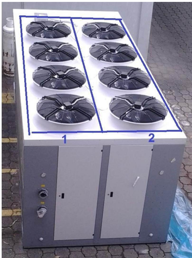
Figura 40. Ventiladores principales del chiller
