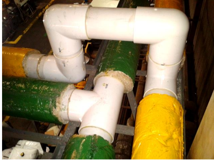
Figura 50. Cruce de dos tuberías de PVC
