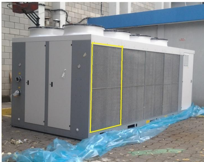
Figura 35. Filtro metálico del condensador
