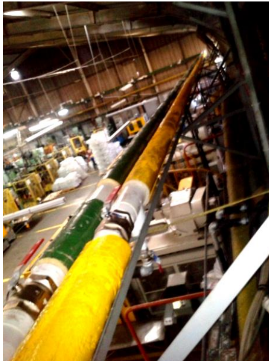
Figura 47. Instalación de tubería central de agua
