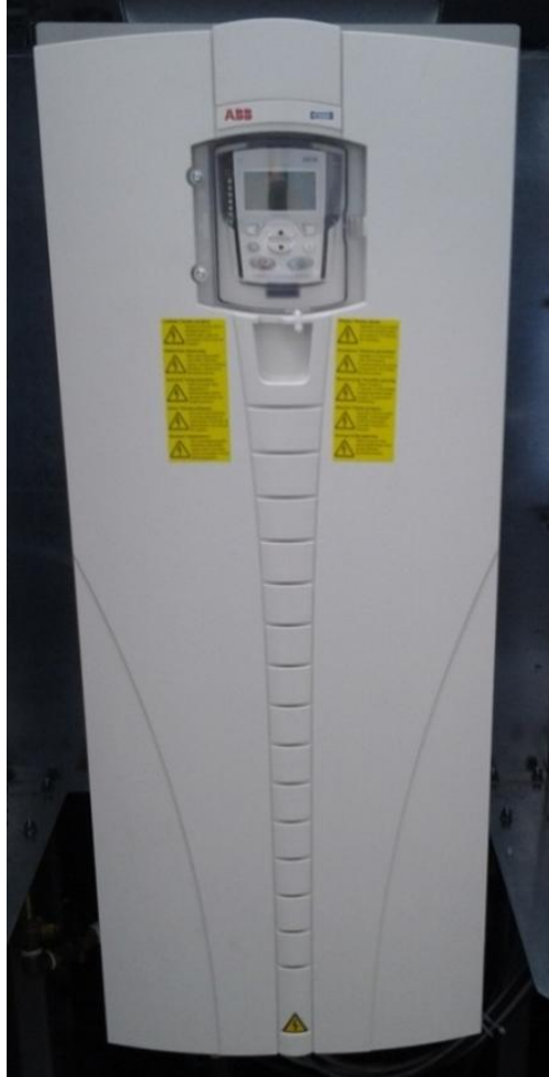
Figura 37. Variador de velocidad del compresor
