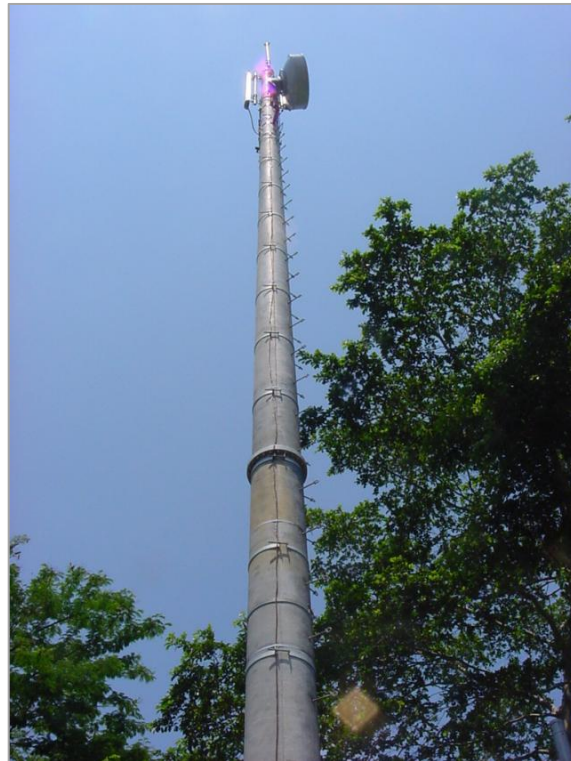
Figura 21. Torre tipo monopolo
