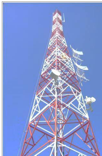
Figura 19. Torre auto soportada
