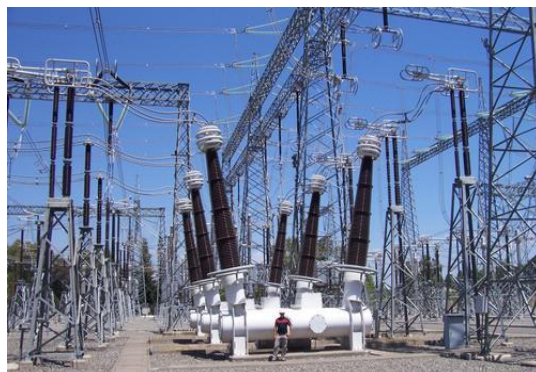
Figura 30. Interruptor de potencia con hexafloruro de azufre (SF6)
