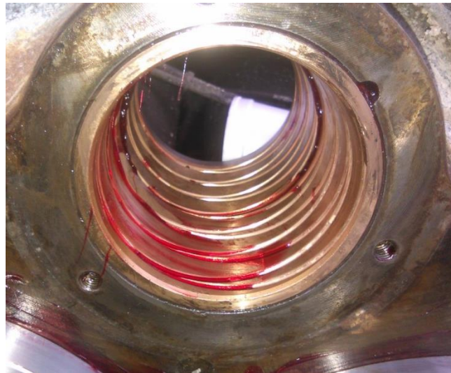
Figura 42. Bushing del eje de la válvula oscilante
