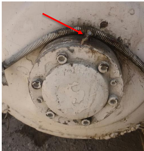
Figura 36. Punto de engrase del agitador del lado derecho
