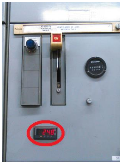
Figura 62. Parte frontal de arrancador con display de corriente del motor
