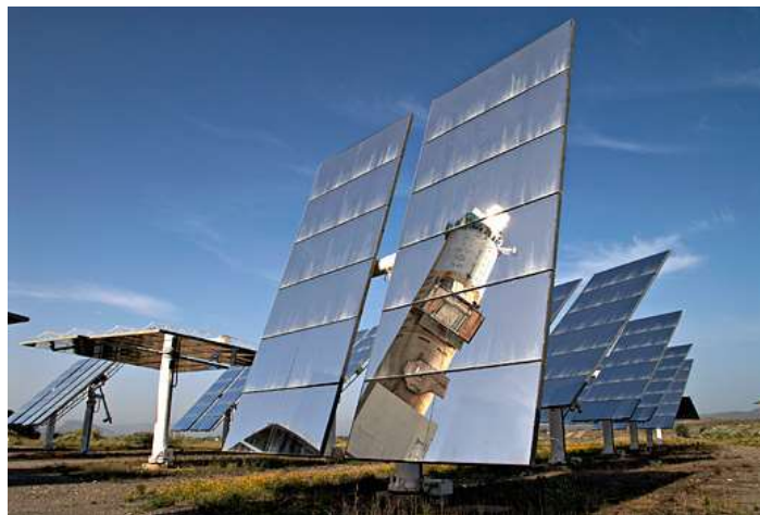
Figura 28. Helióstato con el reflejo de la torre central de CESA-1
