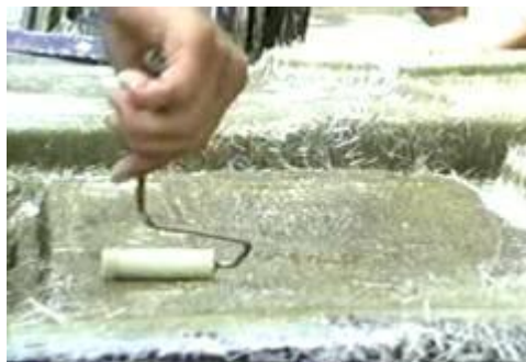
Figura 18. Aplicación de fibra de vidrio
