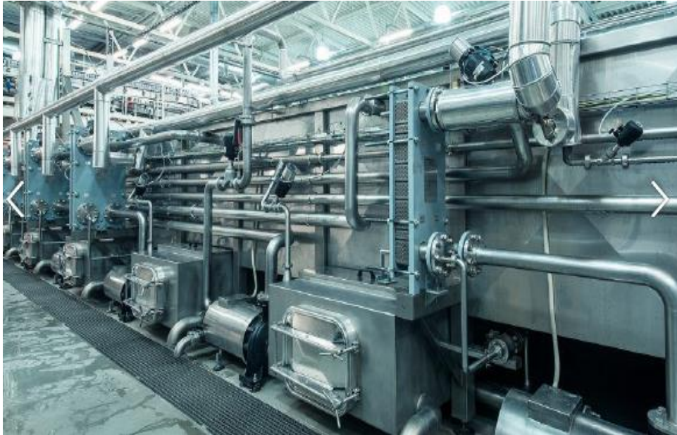
Figura 5. Agua cruda del sistema
