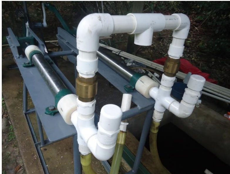
Figura 86. Instalación de cruces, con extremo de tapón roscado para cebar la bomba
