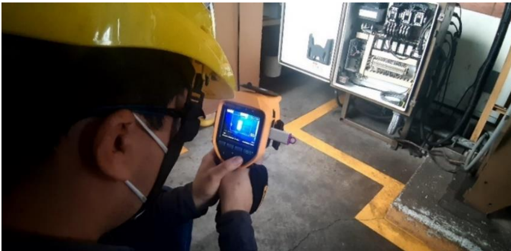
Figura 25. Medición termográfica a panel eléctrico
