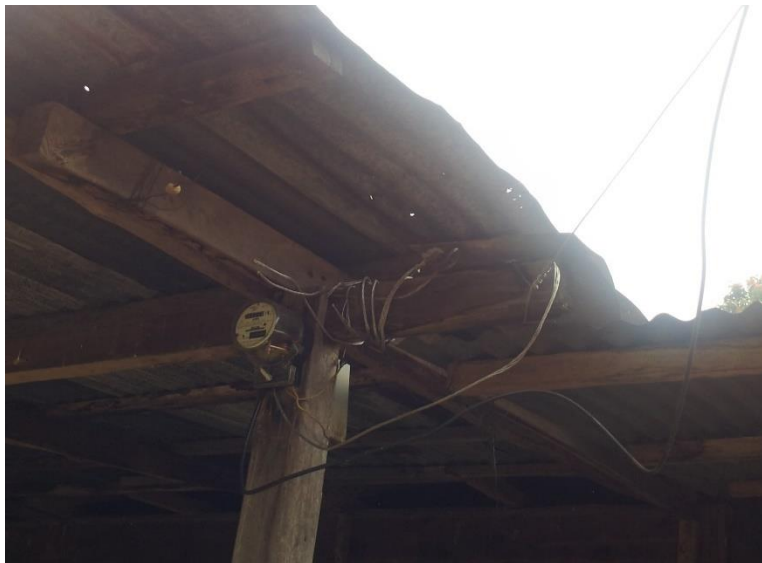
Figura 8. Conductor dúplex # 2 con neutro desnudo marca Condumex, parte 1
