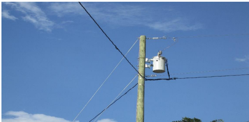
Figura 22. Red de baja tensión con triplex trenzado # 2
