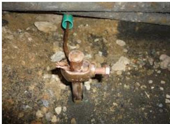
Figura 11. Varilla de cobre con mordaza
