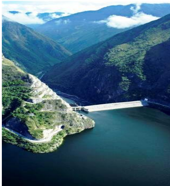
Figura 2. Central Hidroeléctrica Chixoy, Guatemala
