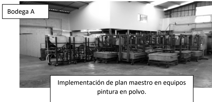
Figura 88. Área de pintura en polvo
