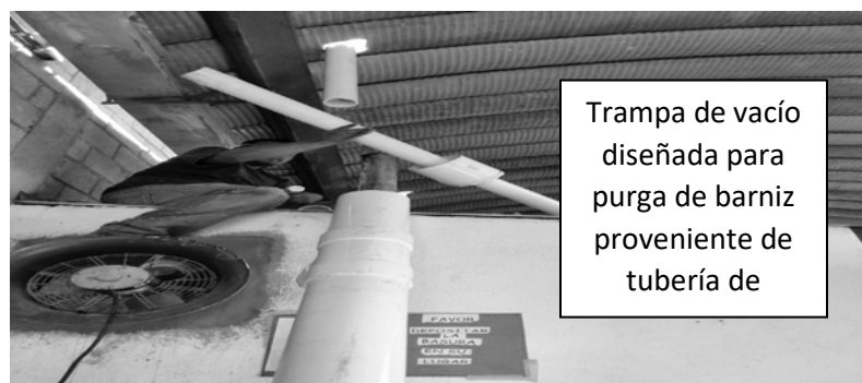
Figura 83. Realización de trampa de vacío
