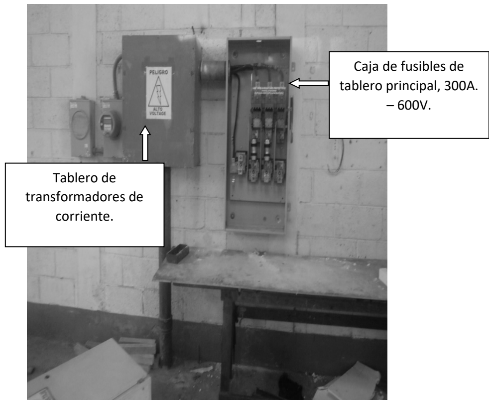
Figura 58. Instalación de tablero principal
