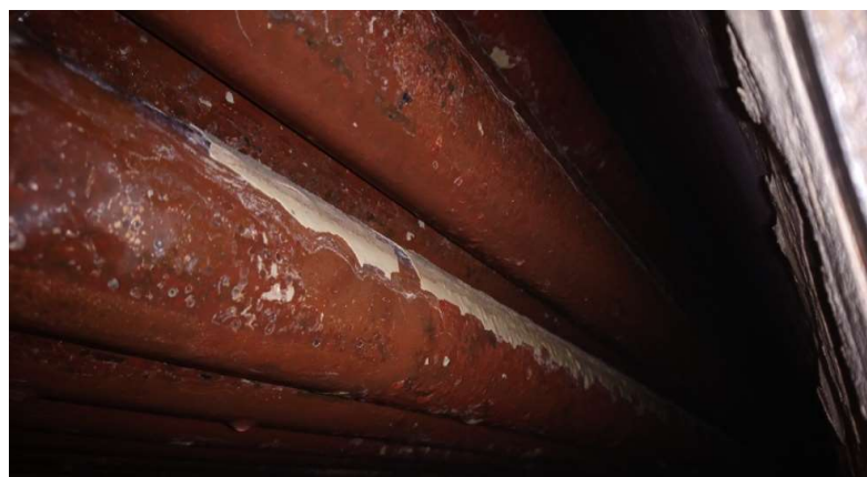
Figura 36. Tubos y pared durante limpieza, vista registro lateral
