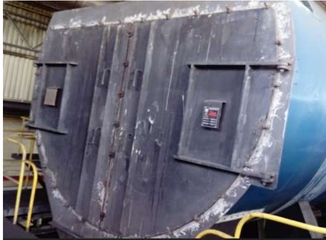
Figura 56. Compuerta frontal sección pirotubular
