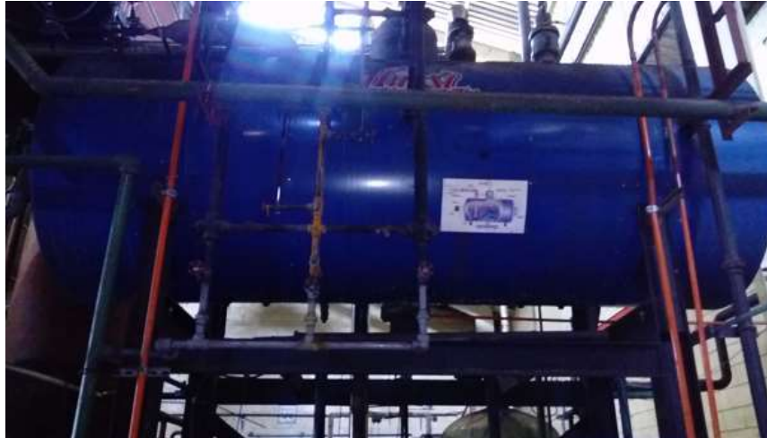
Figura 75. Tanque desaireador
