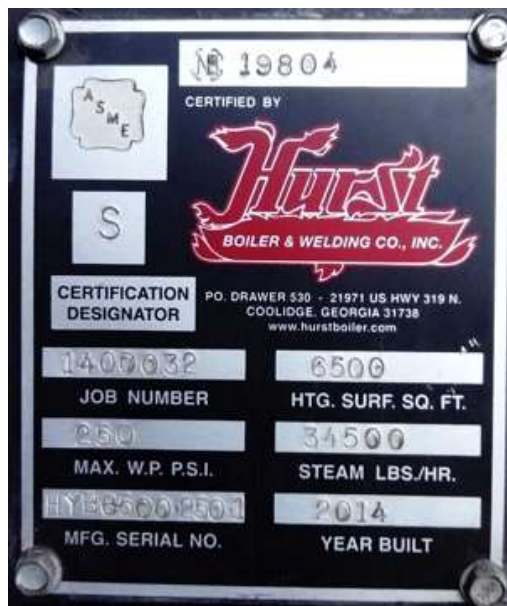
Figura 23. Placa de identificación caldera Hurst 1000BHP
