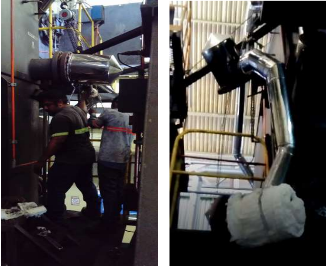
Figura 40. Desmontaje de cabezal de unión doble
