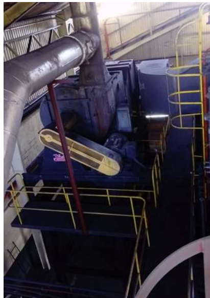
Figura 24. Escaleras y rampa, pasillo chimenea-pirotubular
