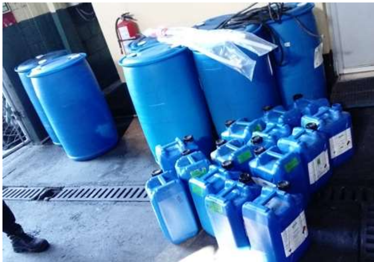
Figura 26. Ubicación de químicos previo a dosificación
