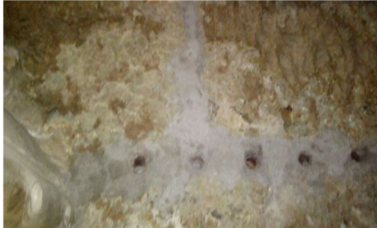
Figura 55. Reparación de fisura, lado derecho
