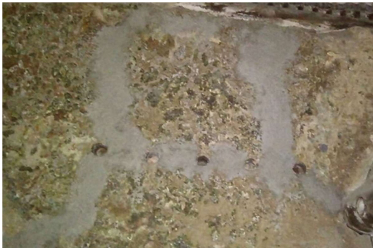
Figura 54. Reparación de fisura, lado izquierdo
