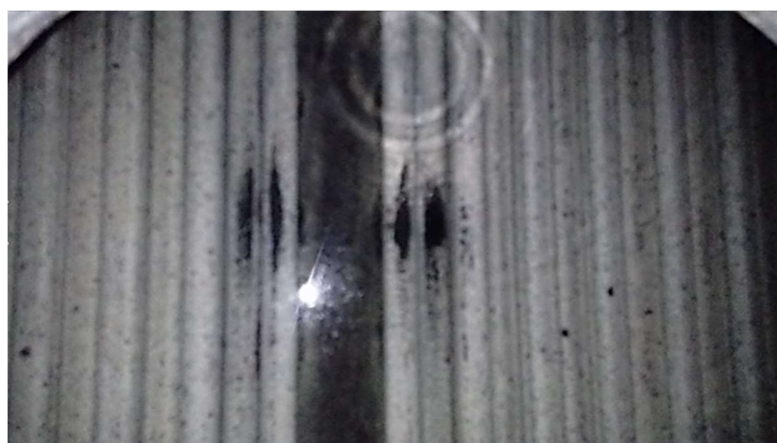
Figura 25. Vista de tubos previo tratamiento
