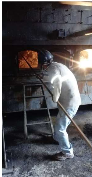
Figura 51. Extracción de ceniza, hogar acuatubular
