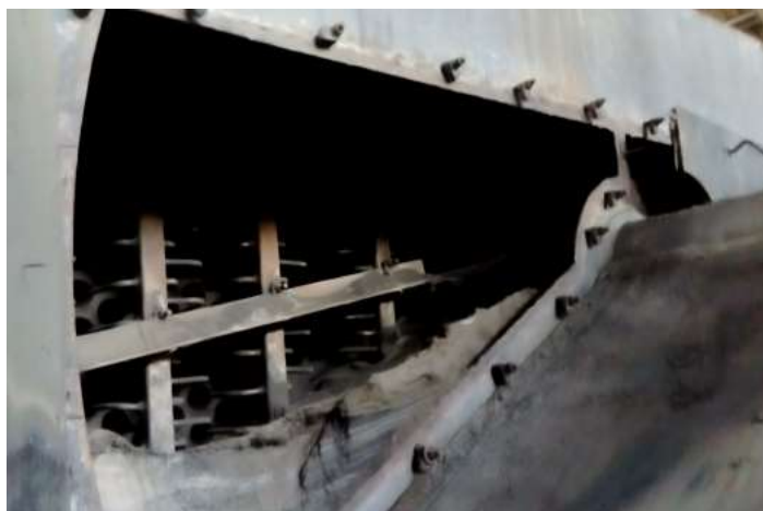
Figura 60. Compuertas traseras de fuego, sección pirotubular
