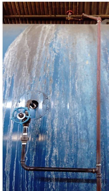
Figura 74. Instalación futura conexión de purga continua
