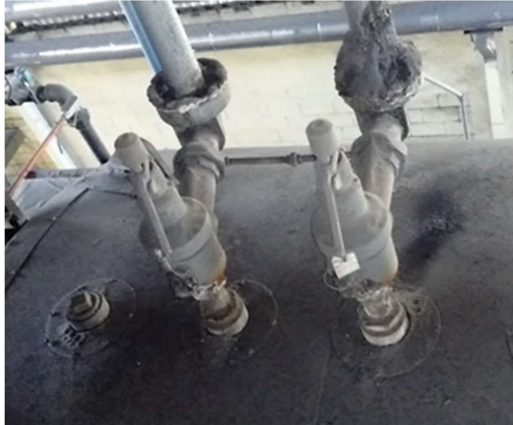
Figura 78. Válvulas de seguridad de caldera acua pirotubular
