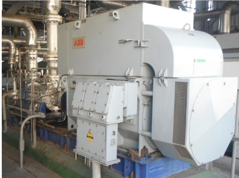
Figura 2. Motor eléctrico de 690 KW para 4 160V
