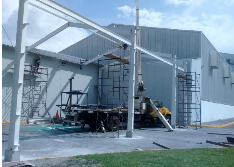
Figura 1. Bodega fabricada con perfiles W
