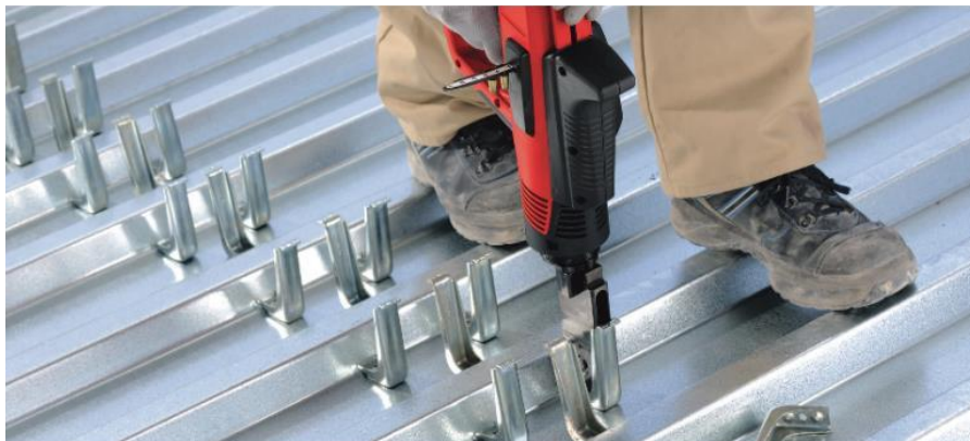
Figura 16. Instalación de pasadores de corte tipo Hilti
