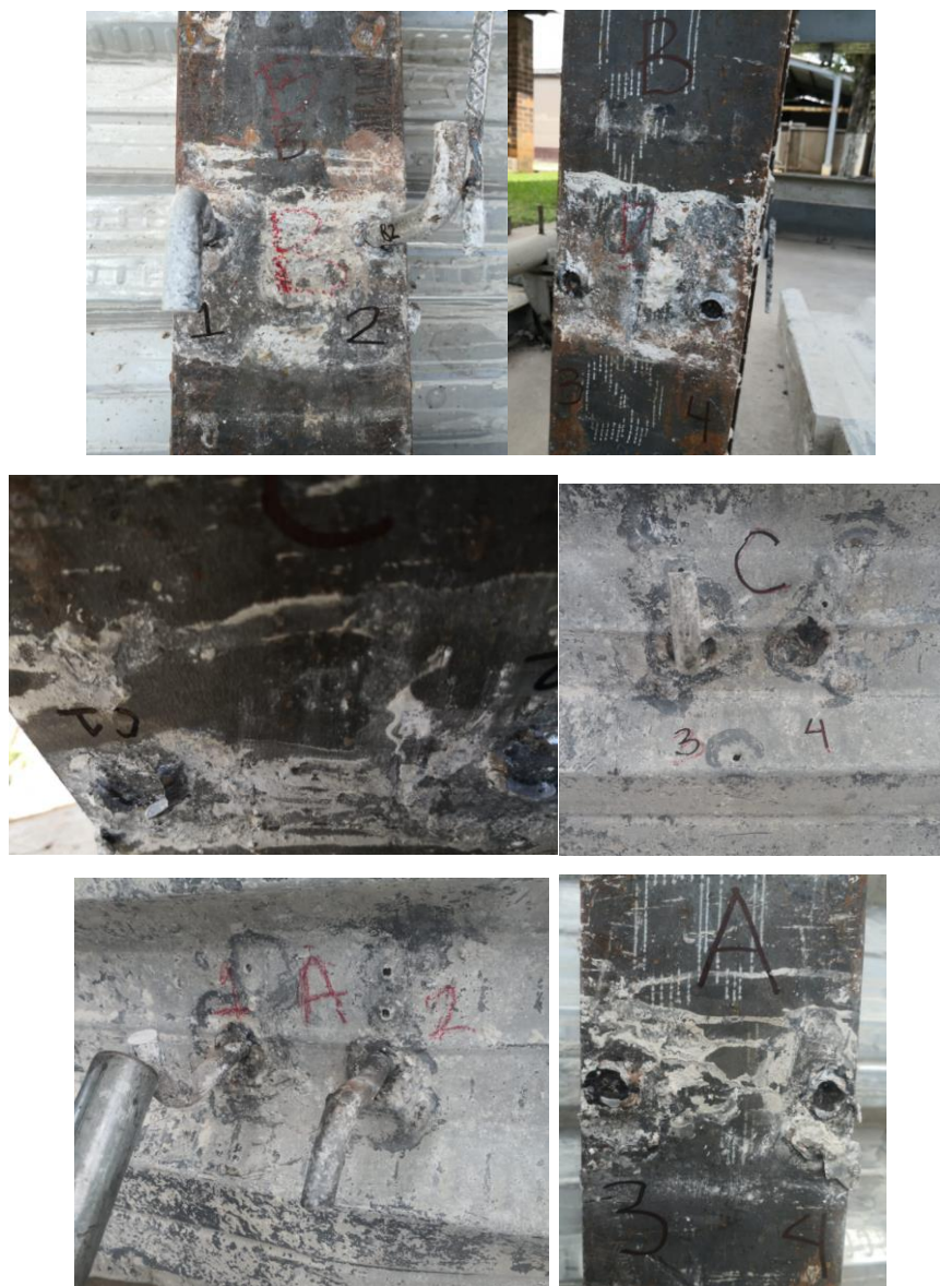
Figura 81. a y b) desprendimiento de pernos en la probeta B. c y d) desprendimiento de pernos en la probeta C. e y f) desprendimiento de pernos en la probeta A
