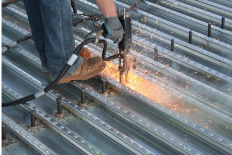
Figura 15. Instalación de pasadores de corte tipo Nelson Stud
