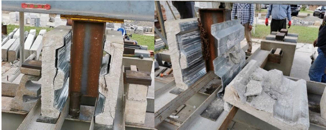
Figura 58. Falla de la Probeta B al alcanzar la carga última
