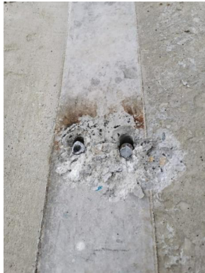
Figura 35. Falla de pernos de anclaje en probeta ensayada
