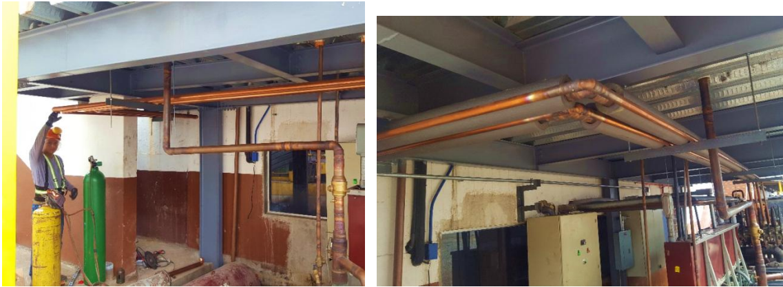
Figura 27. Instalación y conexión de tubería de cobre
