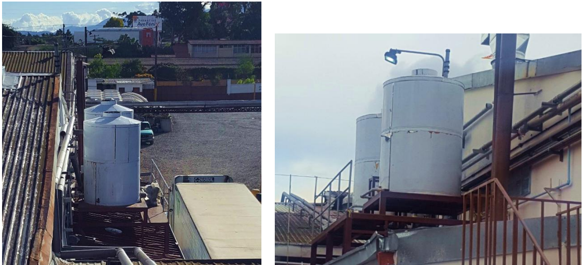
Figura 23. Montaje de tanques de almacenamiento de agua
