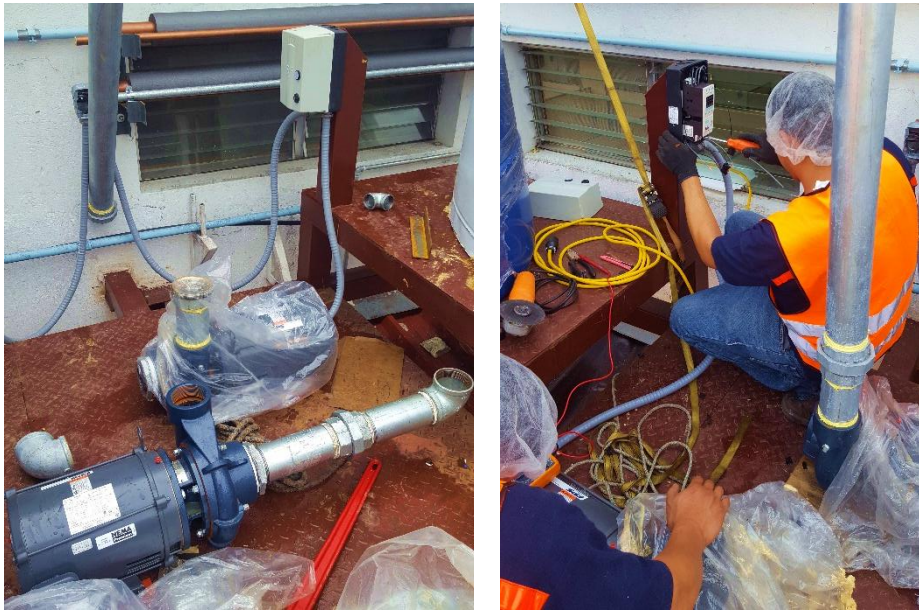
Figura 24. Instalación de bombas centrífugas
