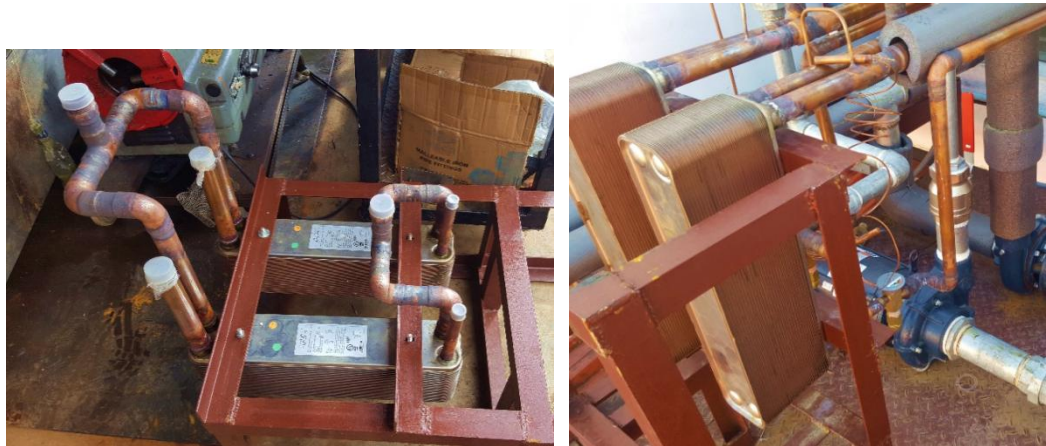
Figura 25. Instalación de intercambiadores de calor
