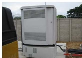
Colocación de BTS
