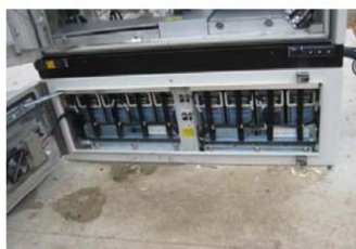
Colocación de Baterías
