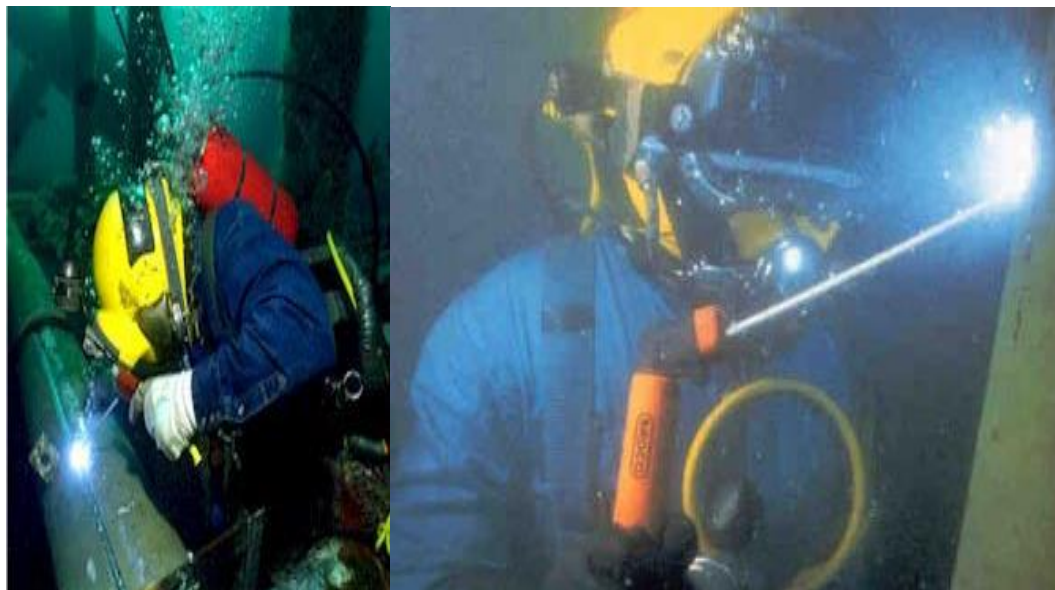
Figura 42. Soldadura húmeda subacuática
