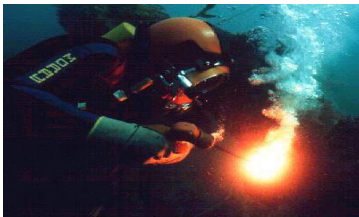
Figura 75. Corte con el proceso de arco-oxígeno
