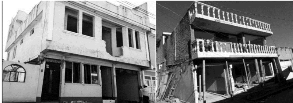
Figura 65. Irregularidad en planta: estructuras tipo túnel
