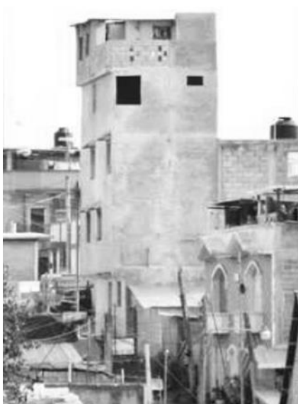
Figura 54. Edificación esbelta y estructura con irregularidad
