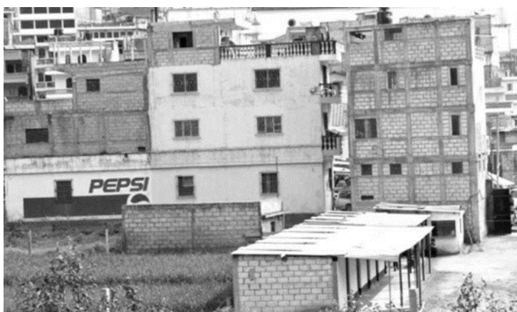
Figura 56. Edificaciones esbeltas y altura mayor a 3 niveles
