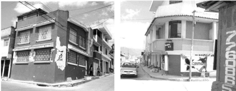
Figura 64. Irregularidad en planta: casa en esquina, otros ejemplos
