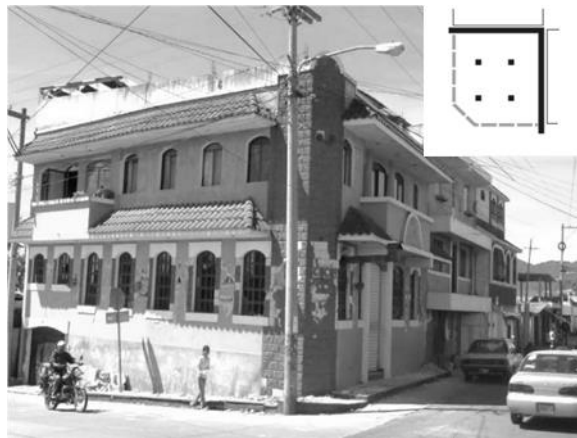
Figura 63. Irregularidad en planta: casa en esquina
