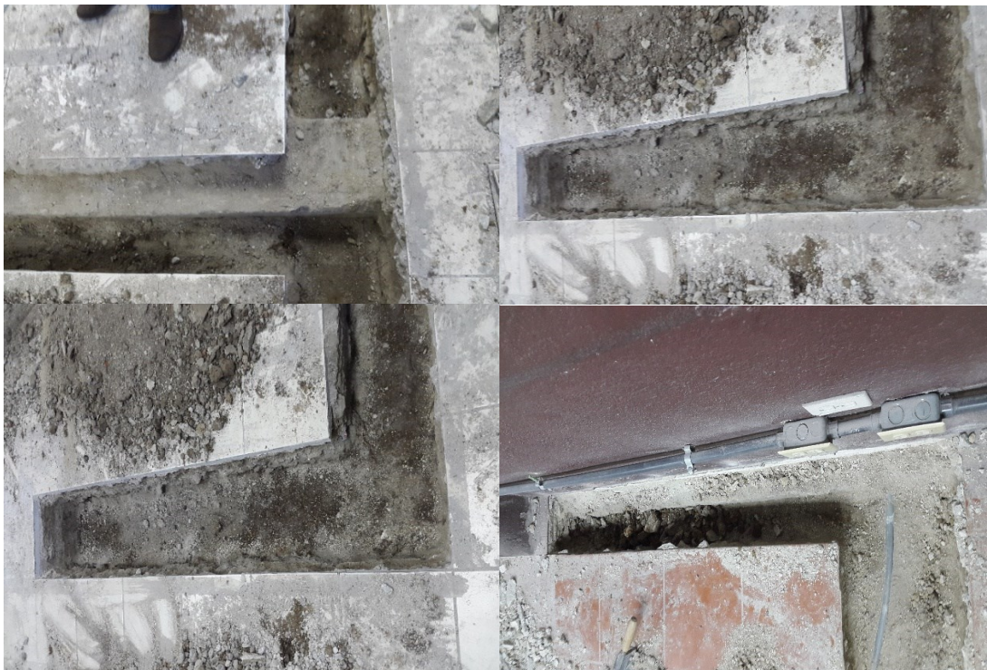
Figura 24. Zanjeado del laboratorio 014
