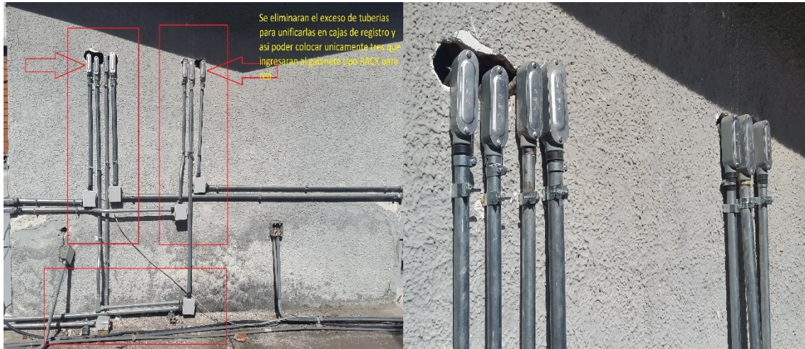
Figura 4. Parte exterior cabina de proyección auditorio Francisco Vela
