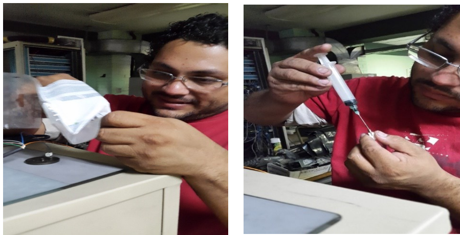
Figura 12. Instalación de conectores SC en la fibra óptica
