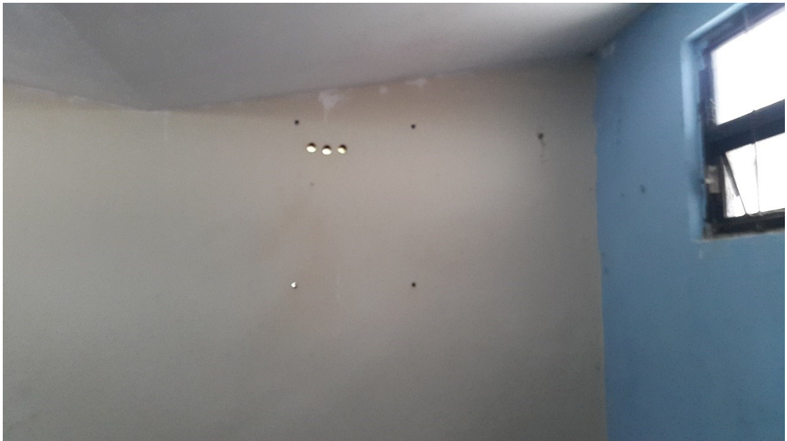
Figura 7. Cabina de proyección después de las reparaciones
