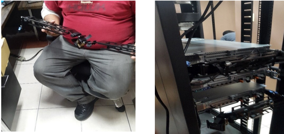
Figura 28. Instalación de los brazos traseros del servidor
