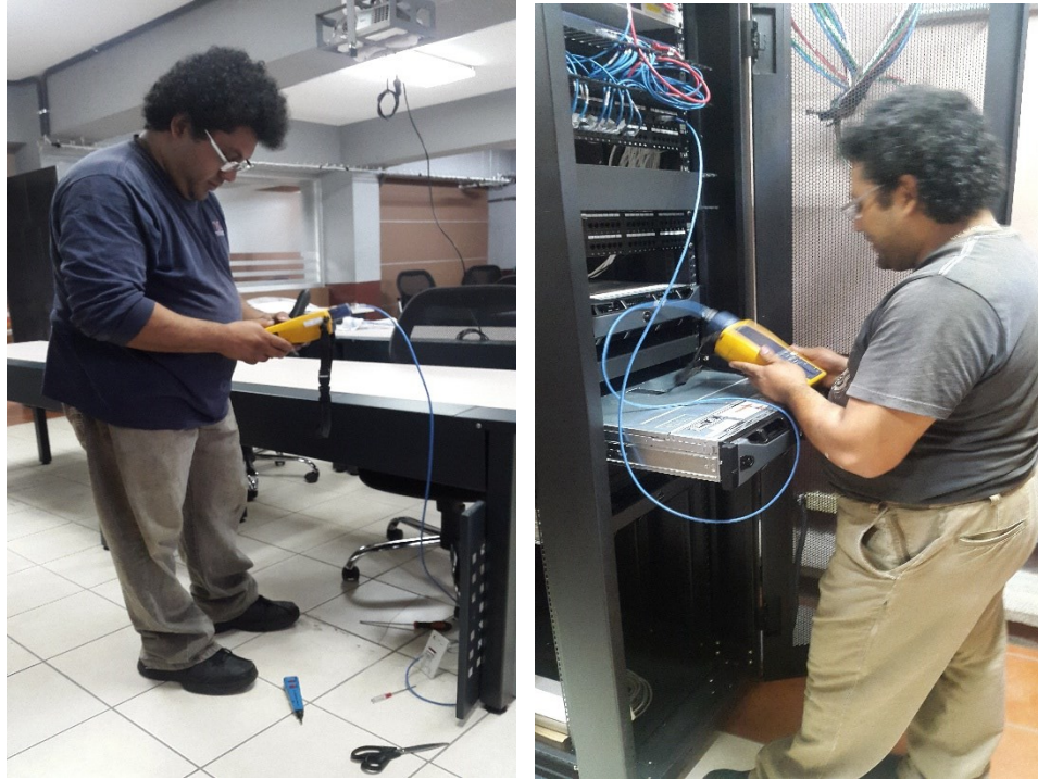
Figura 33. Certificación de puntos de red
