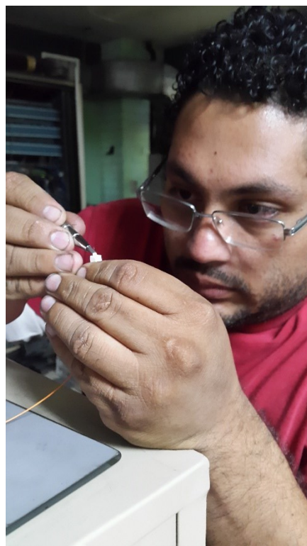
Figura 13. Corte de sobrante de fibra óptica del conector
