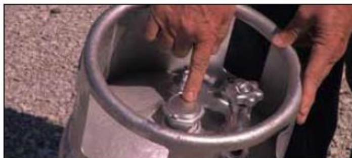
Válvulas e indicadores cubiertos con pintura
