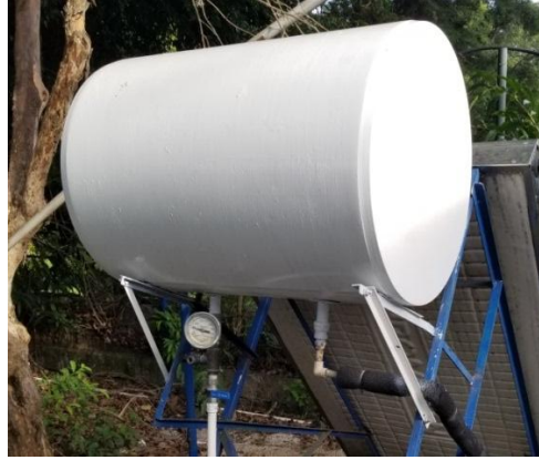
Figura 56. Tanque de almacenamiento después
