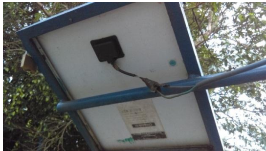
Figura 35. Panel fotovoltaico derecho, antes
