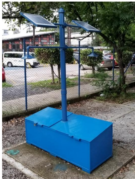
Figura 43. Paneles fotovoltaicos, después
