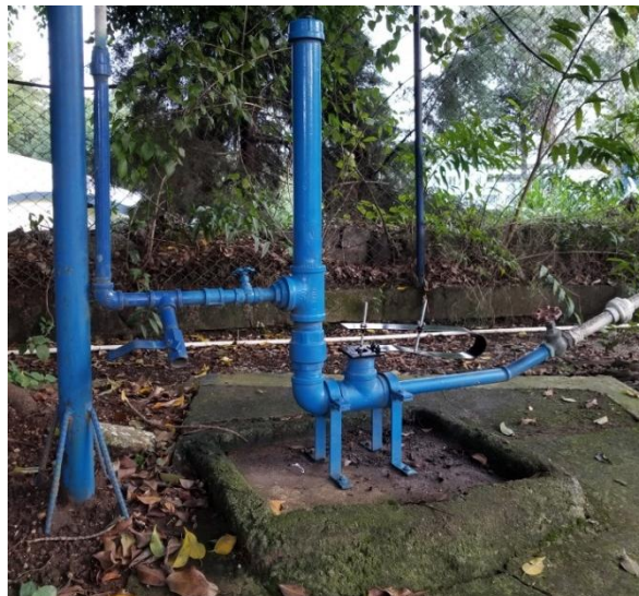
Figura 53. Ariete hidráulico finalizado
