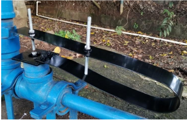
Figura 52. Nuevo muelle instalado
