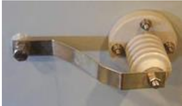
Figura 10. Buje del neutral
