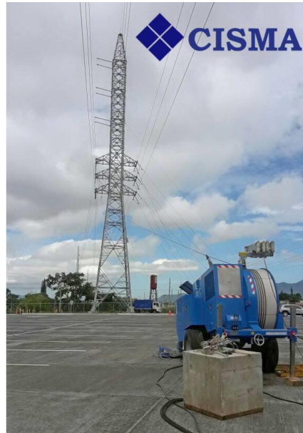
Figura 3. Máquina jaladora de torre 230 KV, doble circuito y doble AZ
