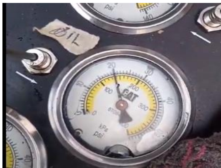
Baja presión de aceite del motor de combustión.
