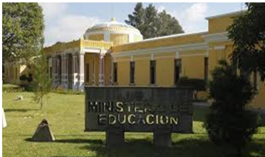
Figura 3. Edificio actual del Ministerio de Educación
