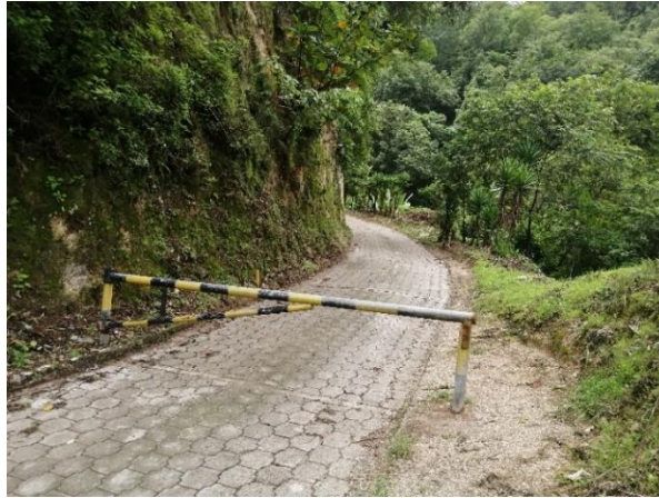
Figura 31. Acceso al área de disposición final
