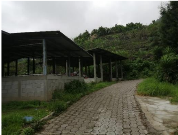
Figura 32. Área de compostaje y reciclaje abandonadas
