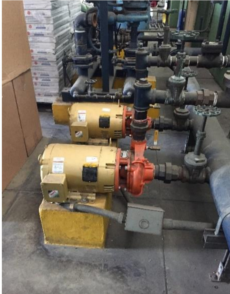
Figura 10. Bomba centrífuga
