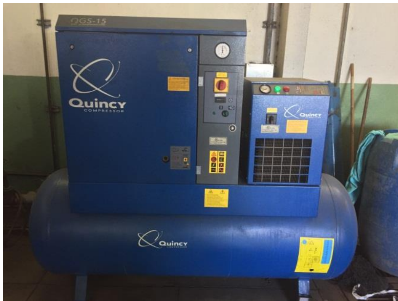
Figura 16. Compresor de tornillo
